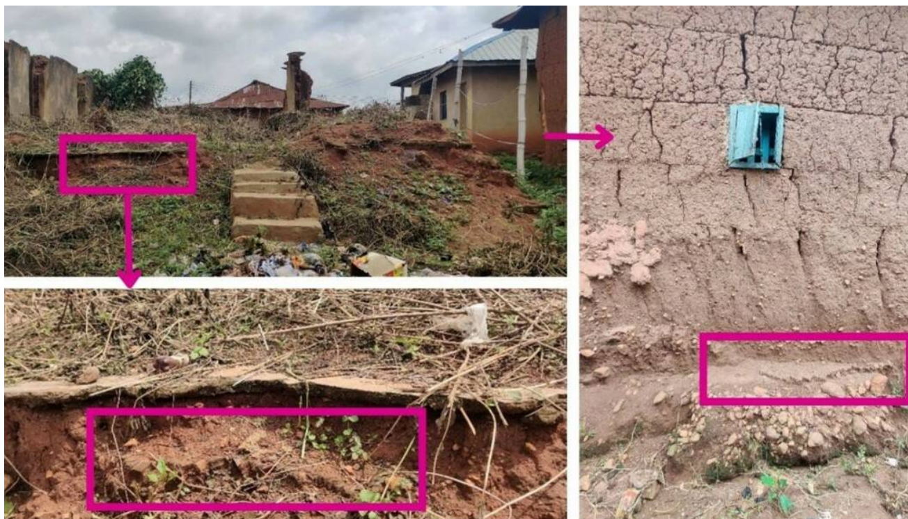
Fig-3 : Vue générale du site de Lújùmò Compound, Ilé-Ifè. Léa Roth 2021.
